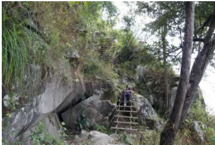
รูปที่ 4 แสดงถึงวัสดุที่ใช้ไม่แข็งแรงเป็นเพียงบันไดไม้ไม่มีราวเกาะ
